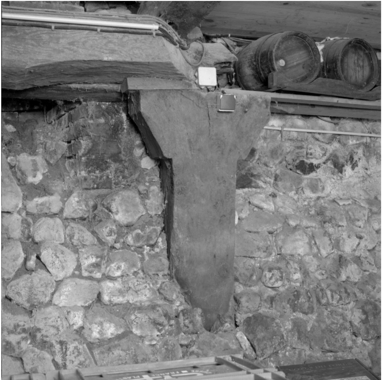
Détail d'un des poteaux de la cave.
