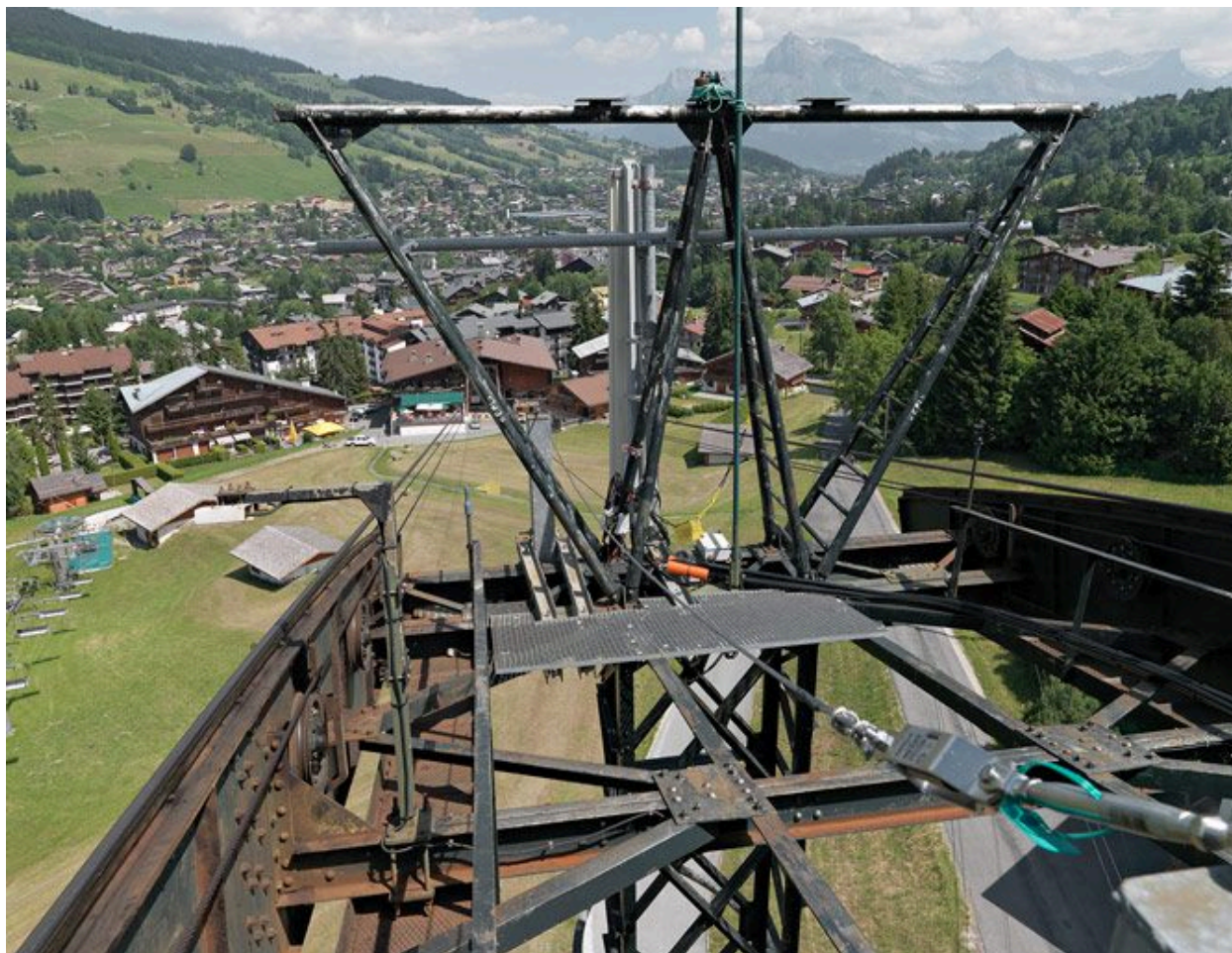
Détail de la tête d'un pylône
