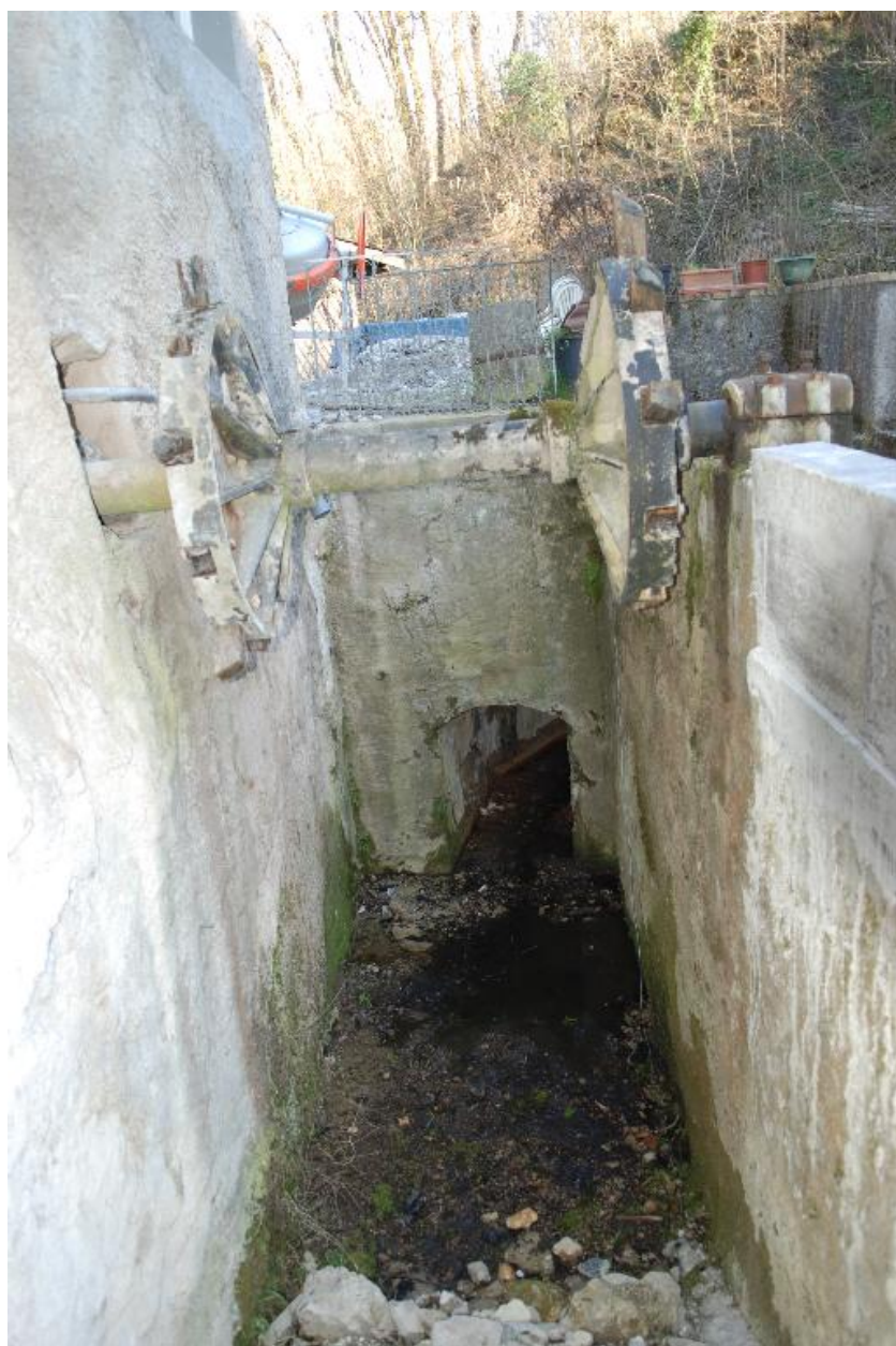
Moulin aval, emplacement ancien de la roue à aube, sens amont.
