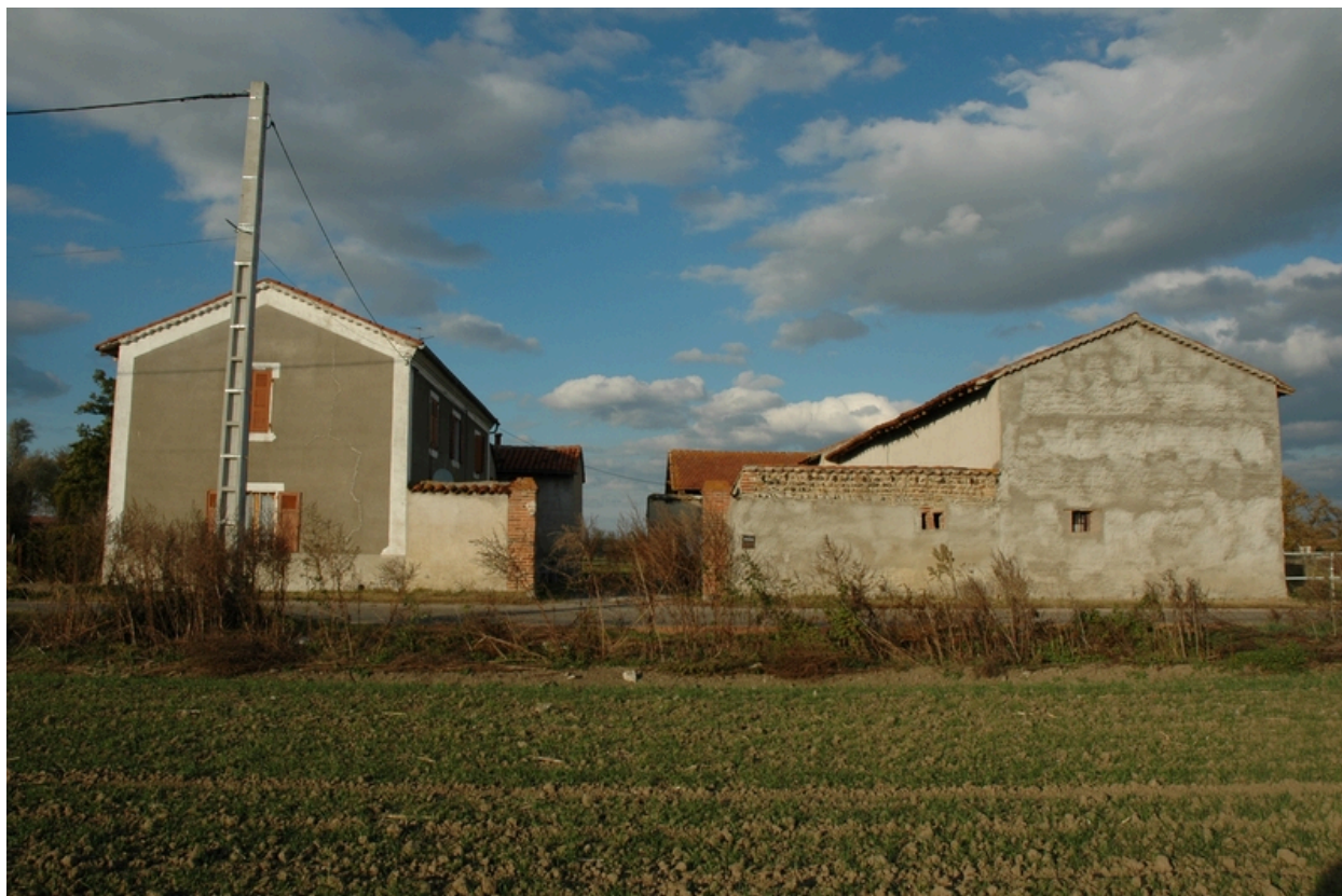
Vue d'ensemble depuis le sud.
