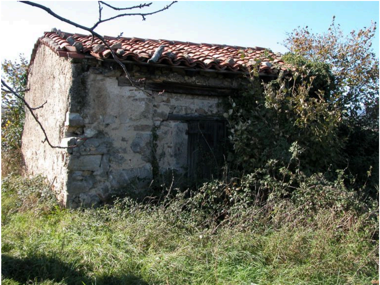
Vue générale de la loge côté extérieur au clos.
