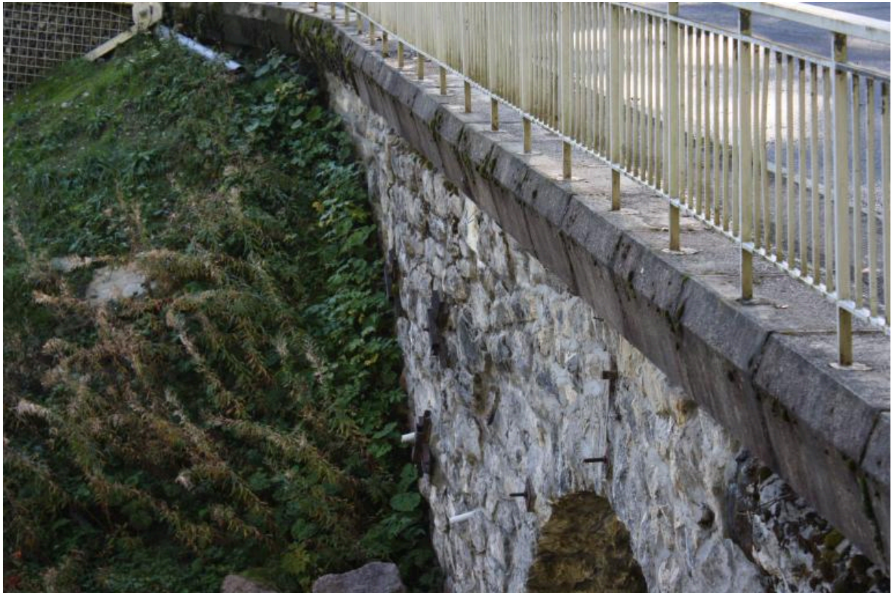
Pont de Dinn; détail plinthes pierres taillées
