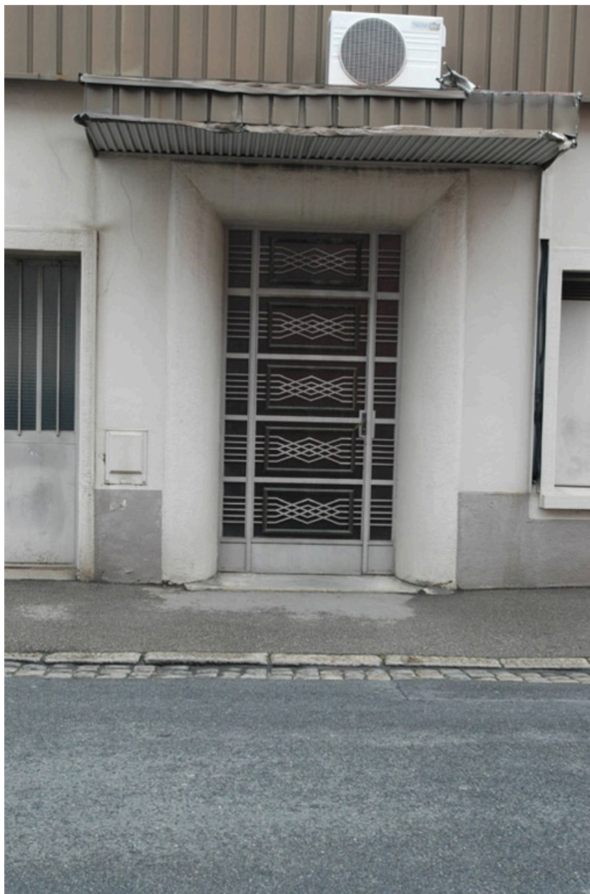
Détail, entrée principale, rue Louise.
