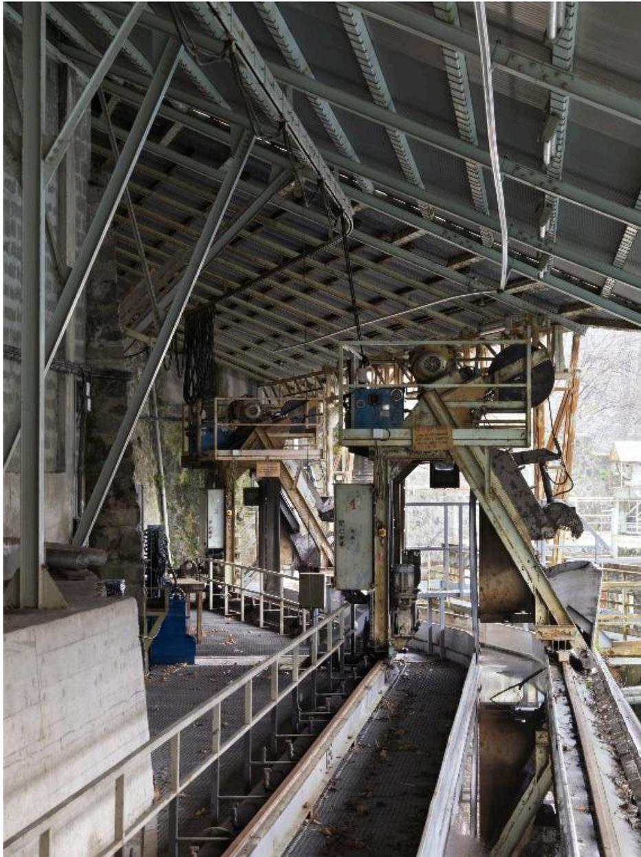
Dégrilleur du barrage de Livet
