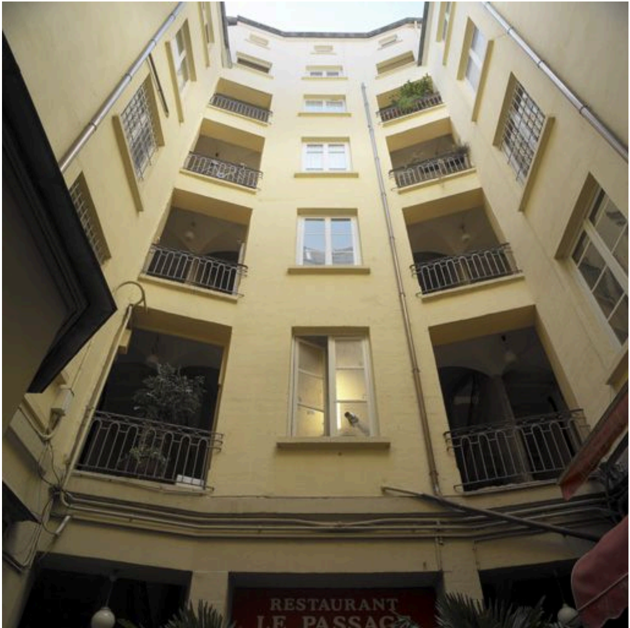
1ère cour, vue du bâtiment en fond de cour avec l'élévation des deux escaliers symétriques
