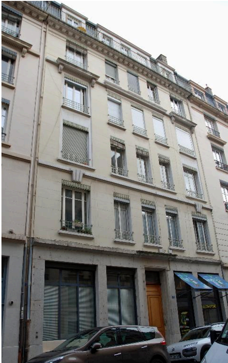
Vue générale de l'élévation sur rue
