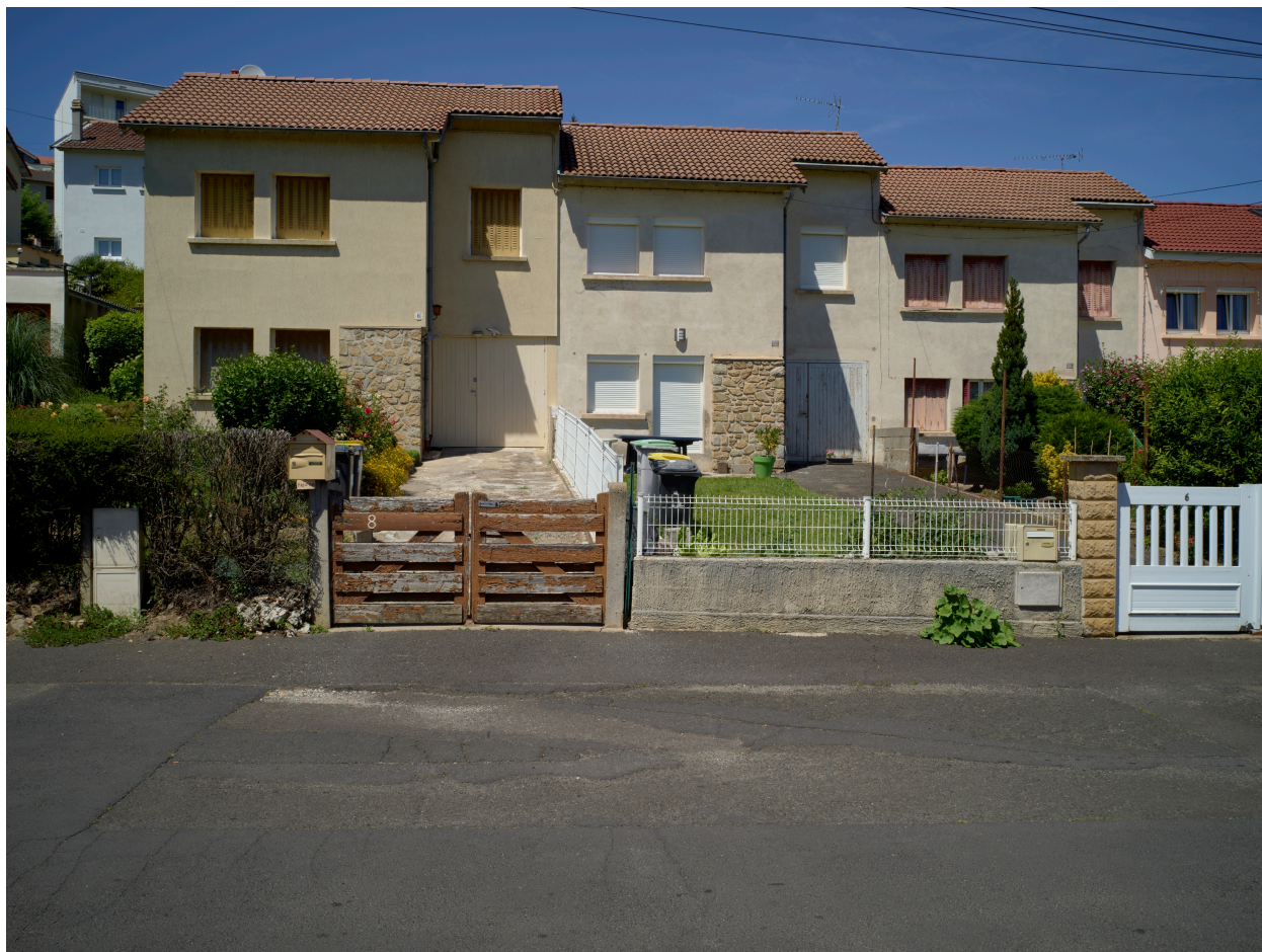
Maisons accolées le long de la rue Georges-Charmeil, au niveau des n°6 et 8.
