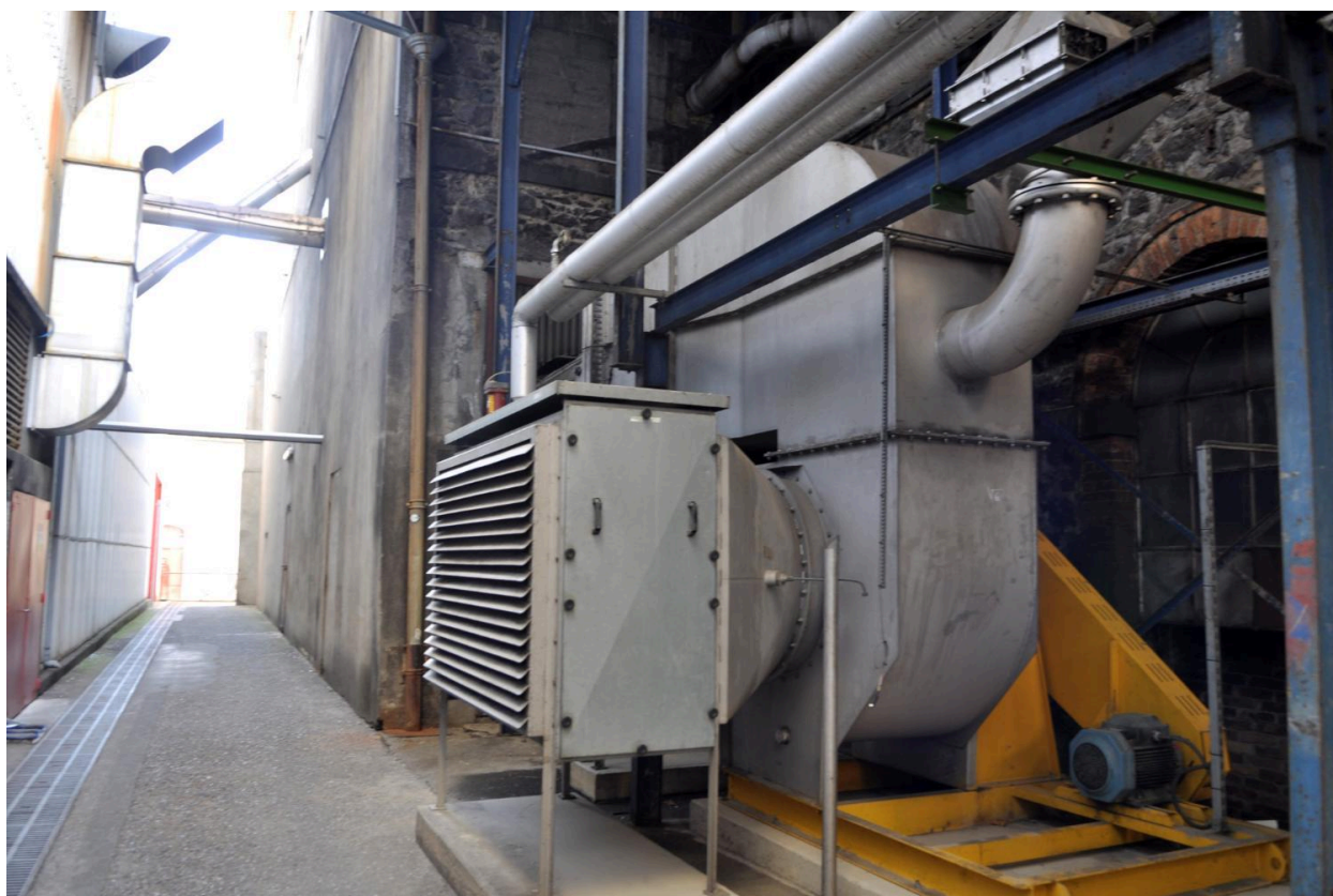
Vue de l'intérieur des ateliers
