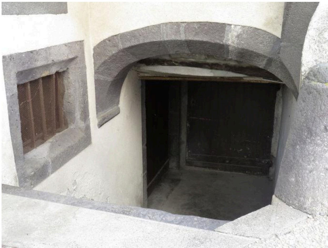
Cébazat, 16 rue Louis Vacher : entrée des caves, vue rapprochée
