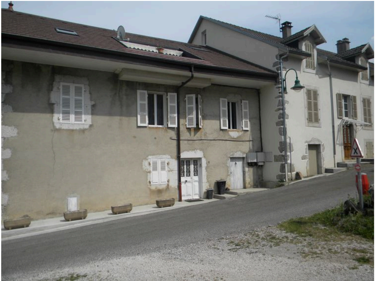
Vue d'une ancienne maison mitoyenne remaniée (2008 A2 974).
