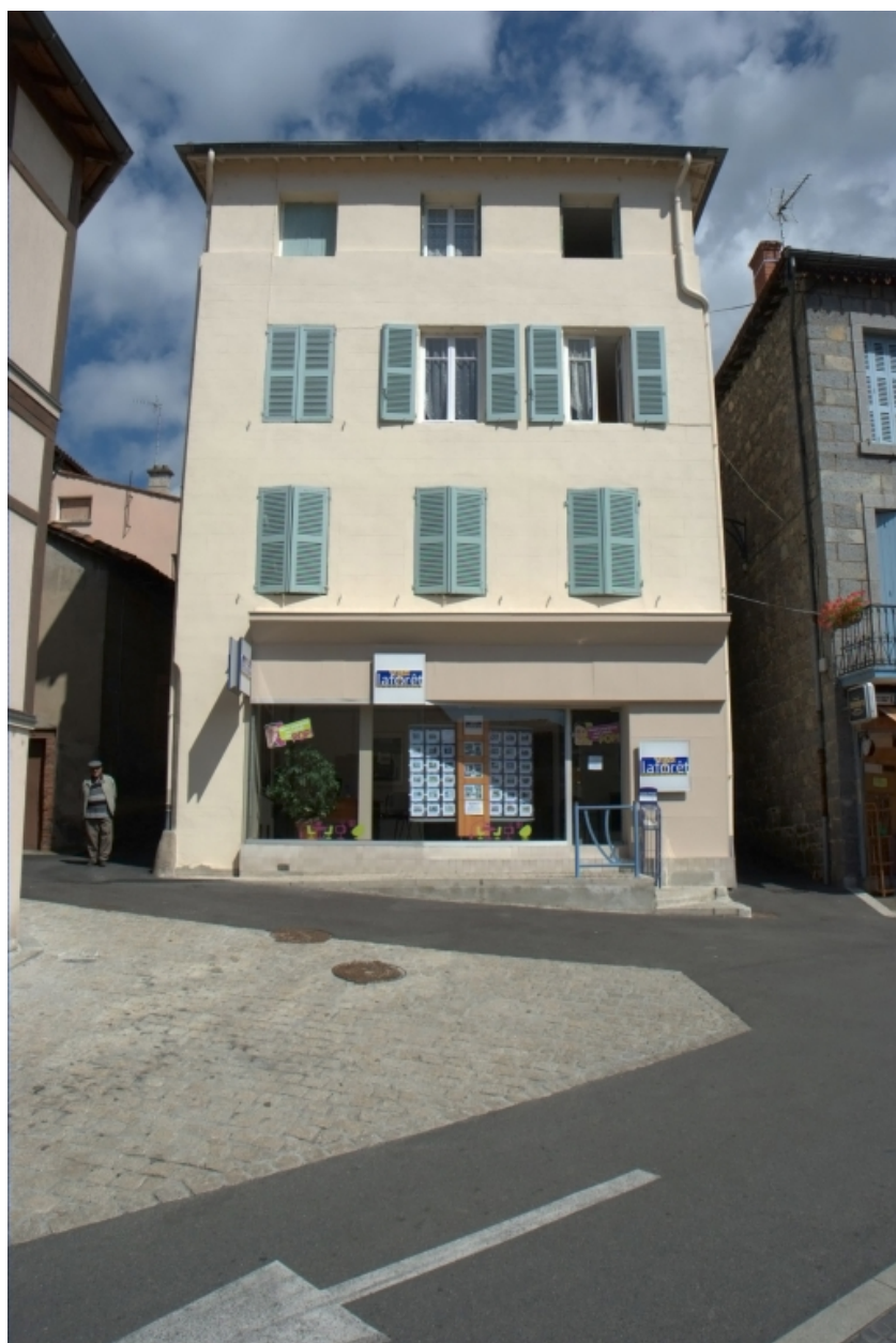
Îlot 3. Victoire (place de la) 06. Vue générale de la façade sur rue.
