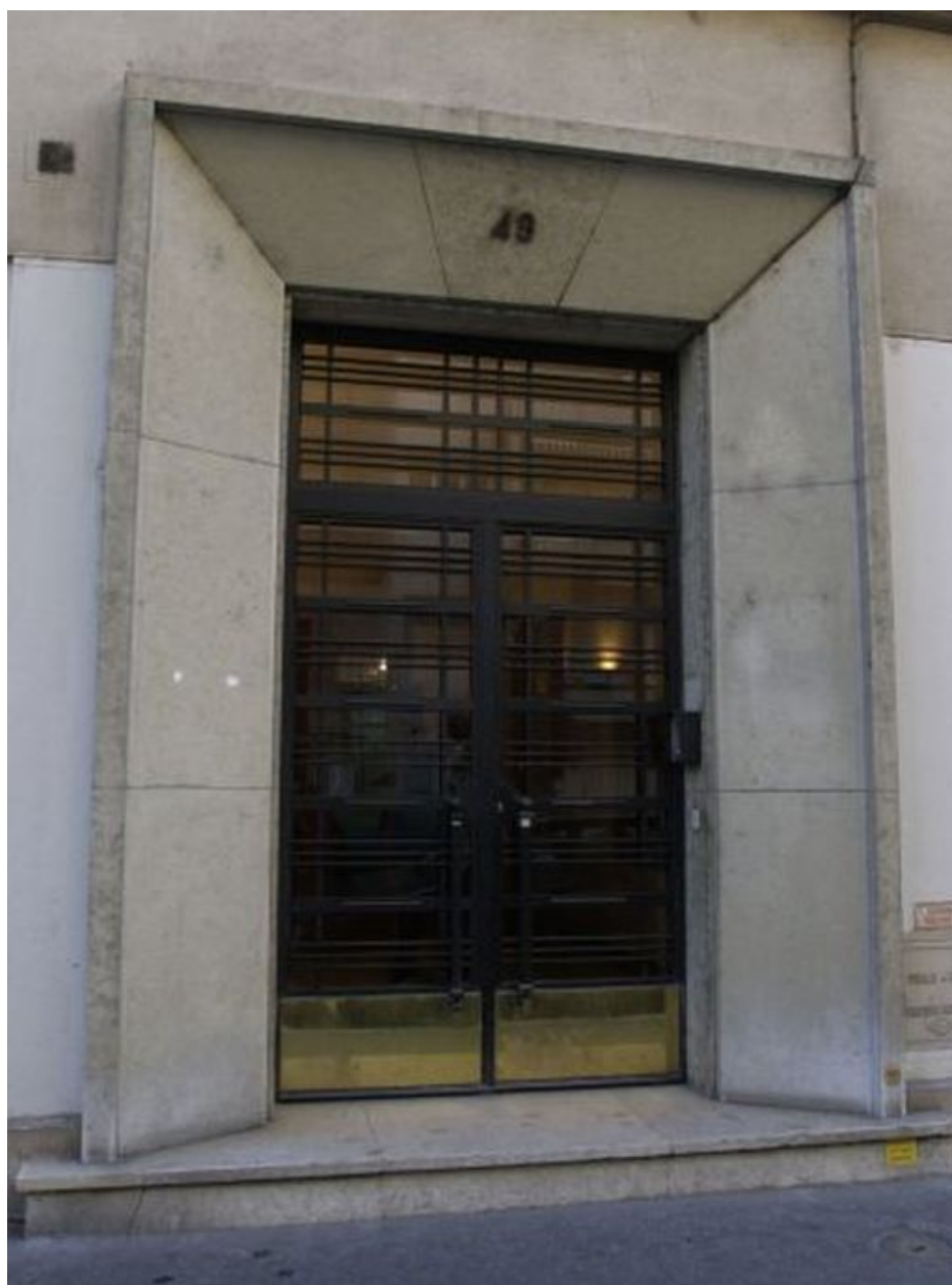
Porte d'entrée 49, rue de Créqui
