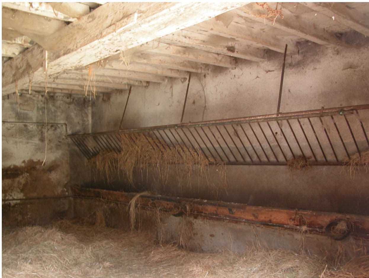
Vue intérieure de l'étable.
