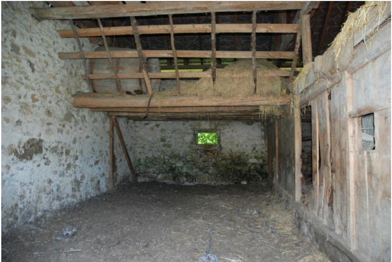
Vue intérieure de la grange.
