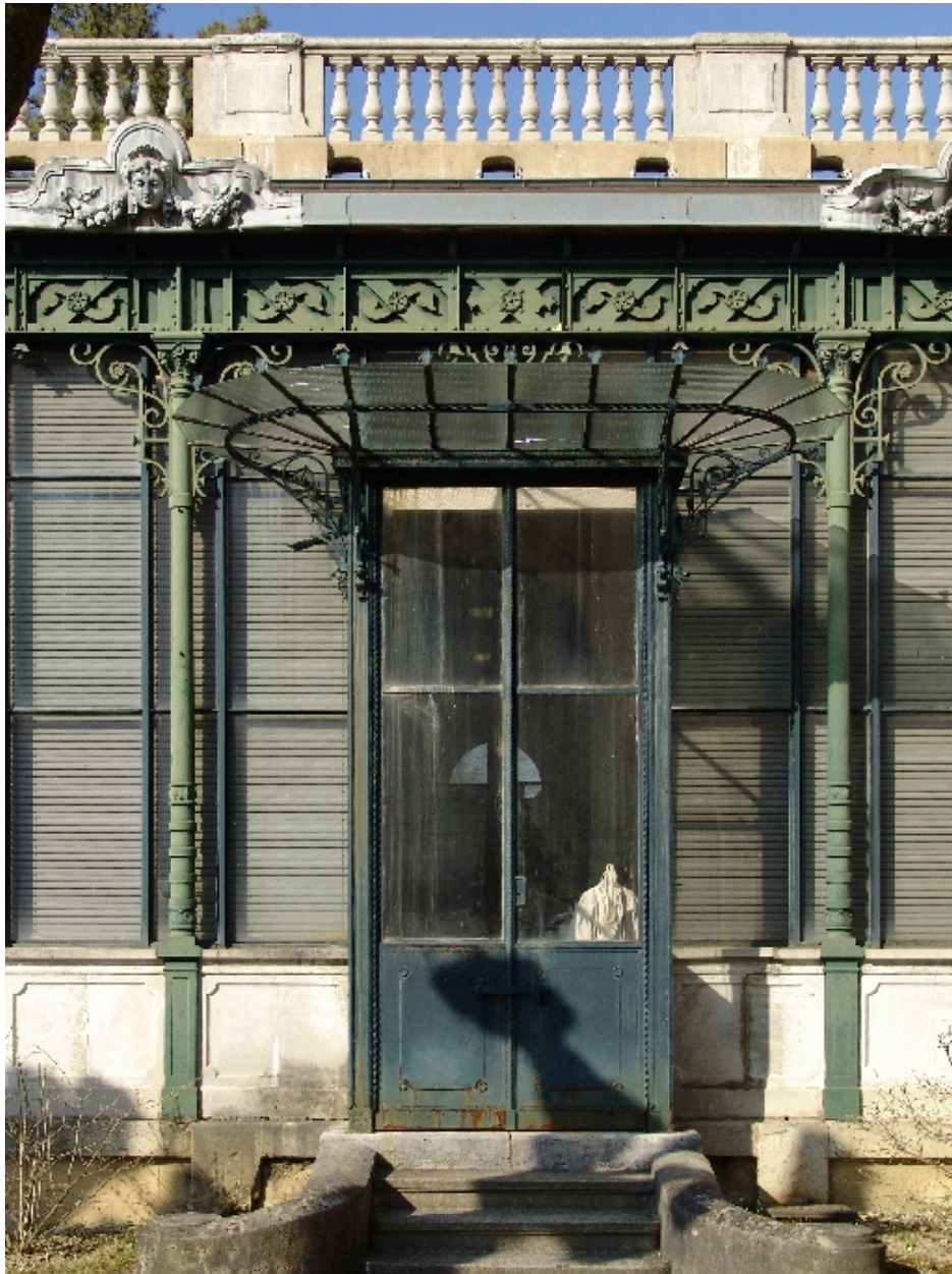
Détail de la galerie nord sur terrasse
