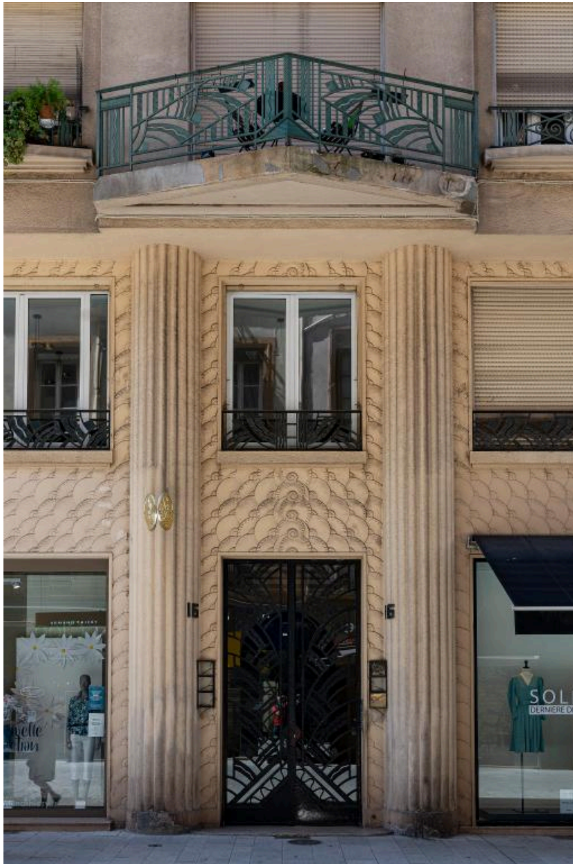
L'entrée de l'immeuble : vue générale
