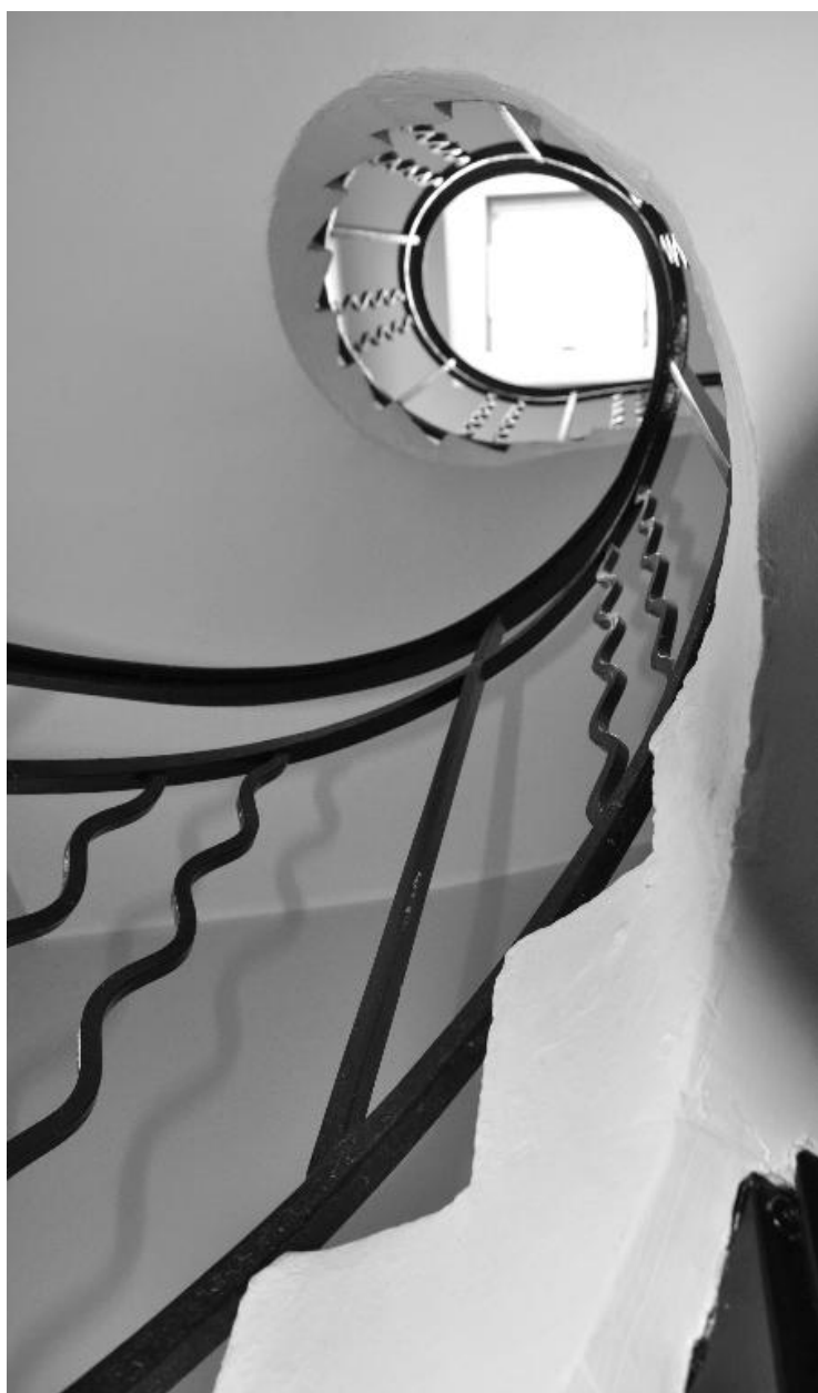
Bât. A : escalier de l'appartement du proviseur
