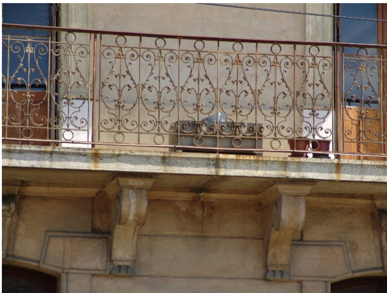
Détail d'un balcon du 1er étage
