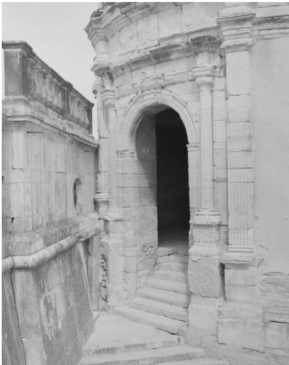
Bâtiment sud. Tour sud-ouest. Porte du passage vers la cour du Puits.
