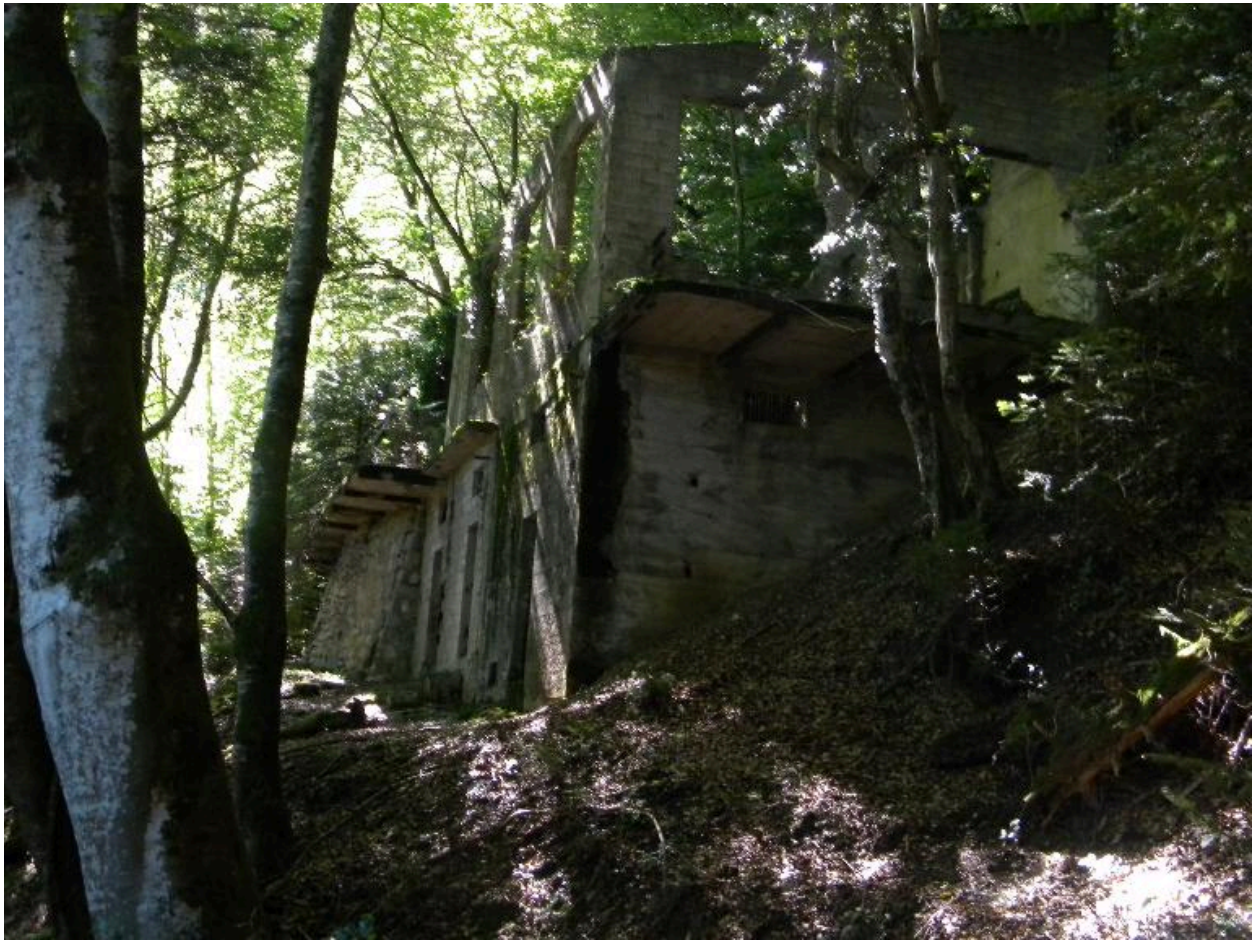
Vue d'ensemble du premier bâtiment depuis le nord.
