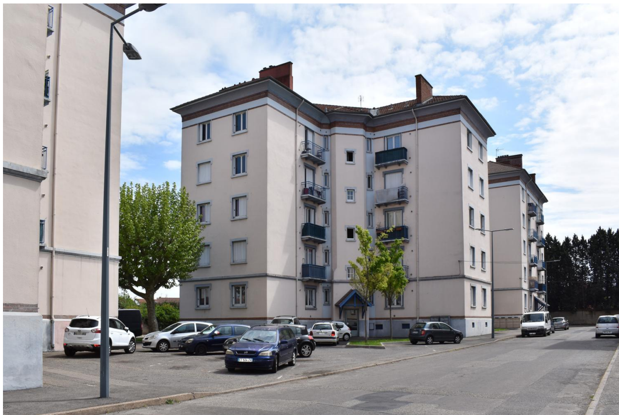
Cité P.L.M. Square André Lebon - détail d'un bâtiment
