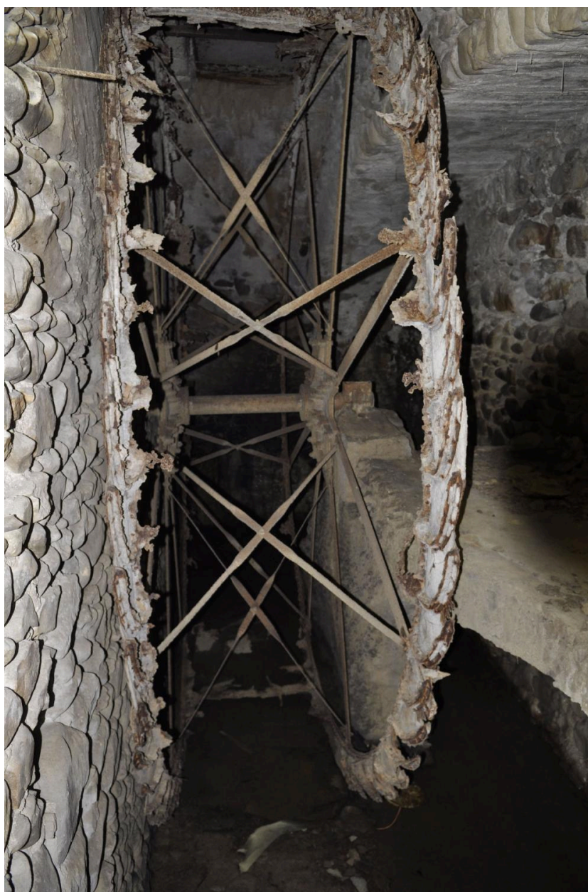
Roue de l'ancien système hydraulique (vue d'intérieur)
