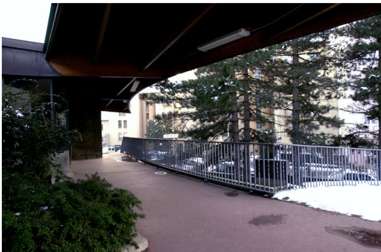
Détail de la coursière
