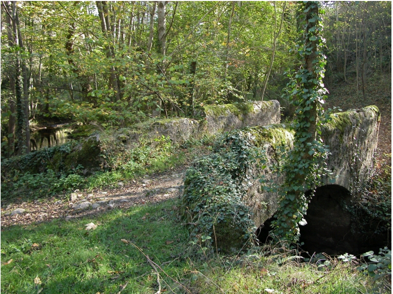
Pont sur le Vizézy à Essertines-basses (non repéré, 1986 D et H non cadastré, vers D 307).
