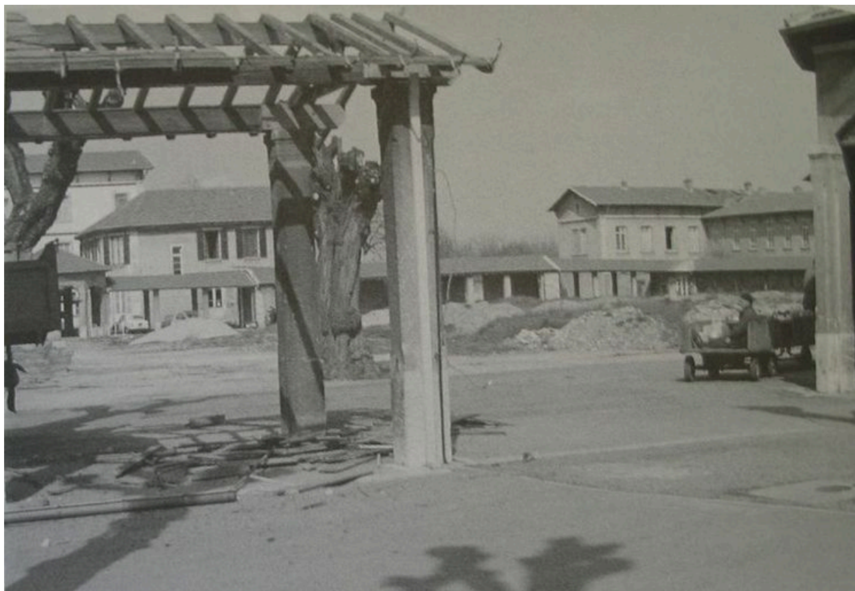
Portiques à usage de promenoir en cours de destruction, vers 1960
