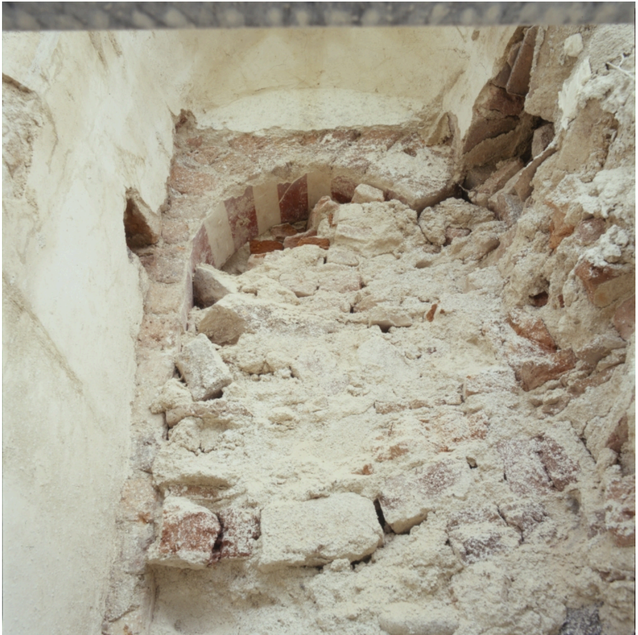
Façade sur jardin du corps de galerie, après décroustage : détail d'une baie en arc plein-cintre à l'intrados présentant un enduit à rayures ocre rouge et blanc.
