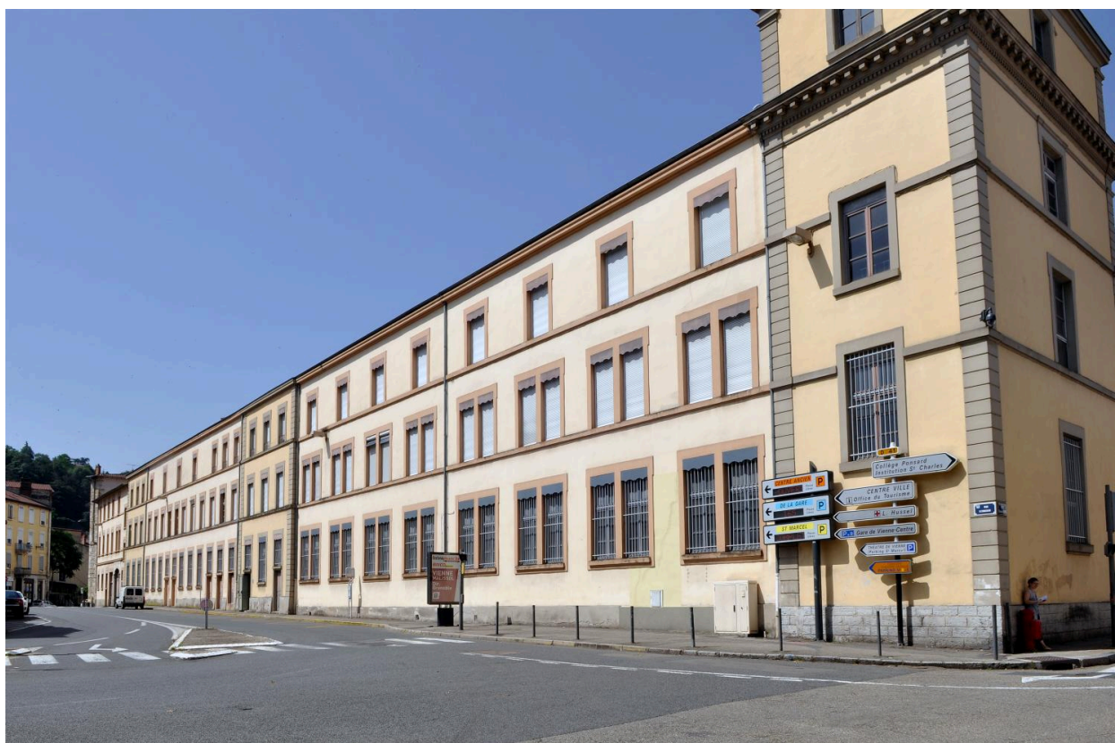
Elévation postérieure, depuis le nord
