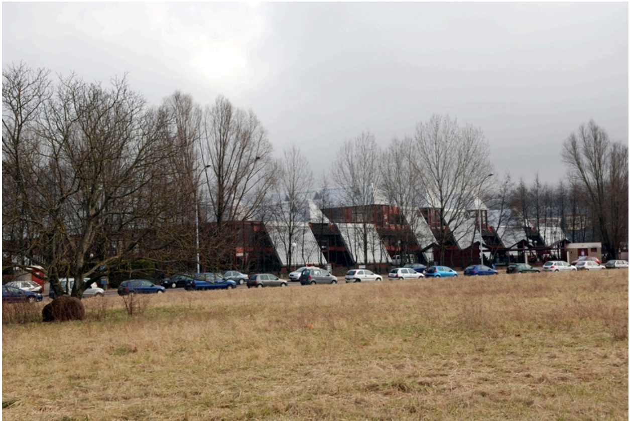
Bâtiment A. Vue d'ensemble depuis l'ouest
