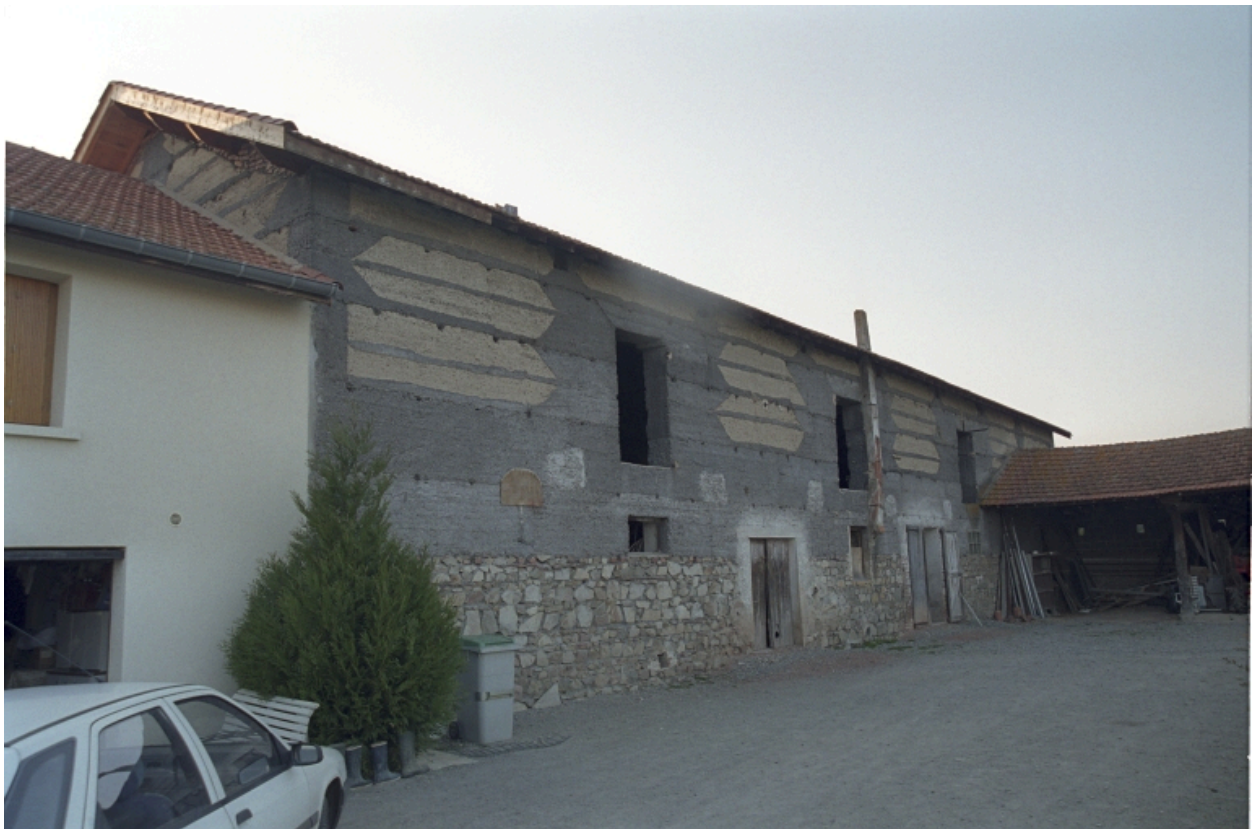
Boën, la Chaux-est, ferme (1986 AE 294). Grange-étable en pise de terre et pisé de mâchefer (milieu 20e siècle).
