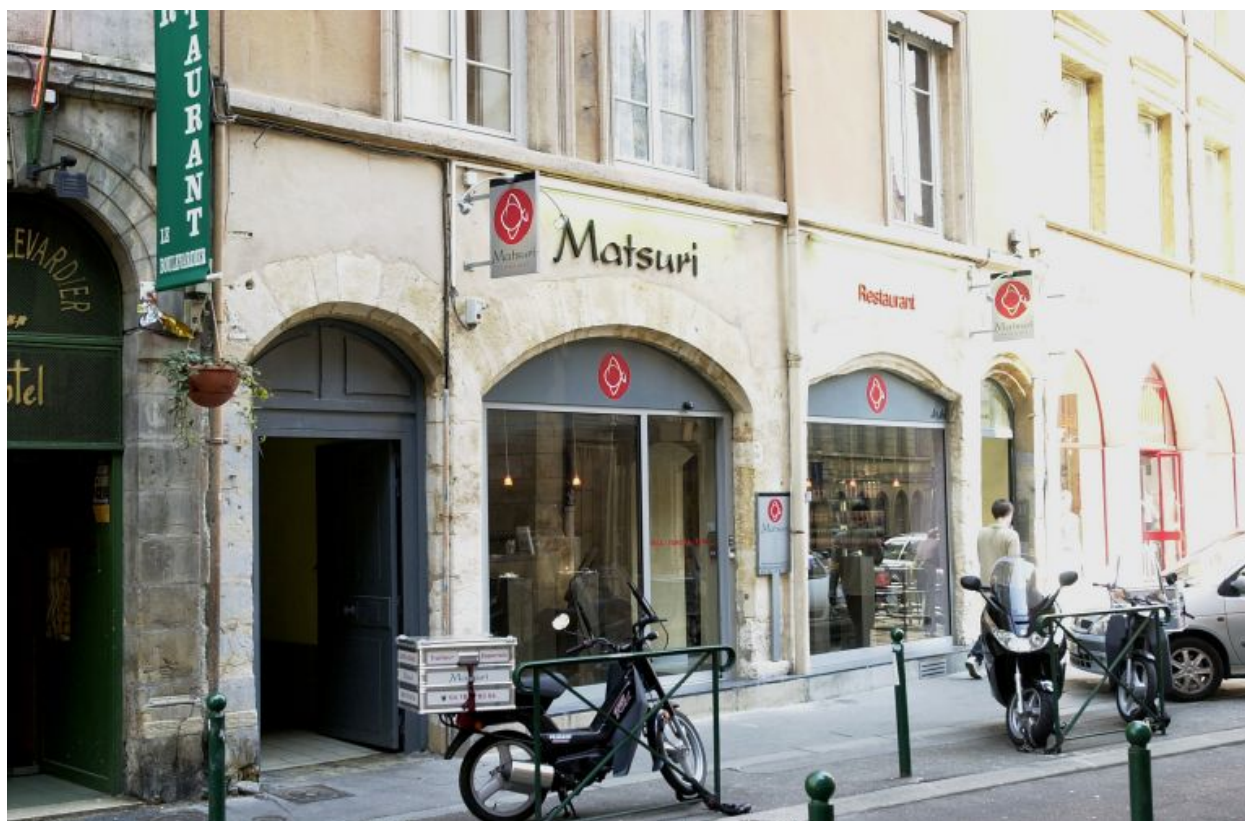
Façade sur rue, rez-de-chaussée
