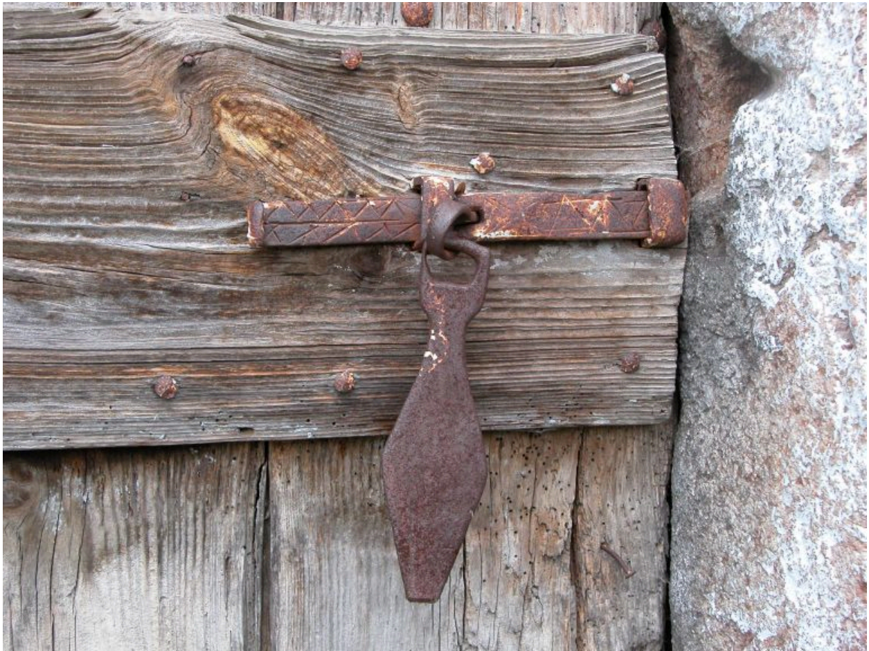
Détail de la porte de l'étable nord-ouest : verrou métallique à pêne gravé.
