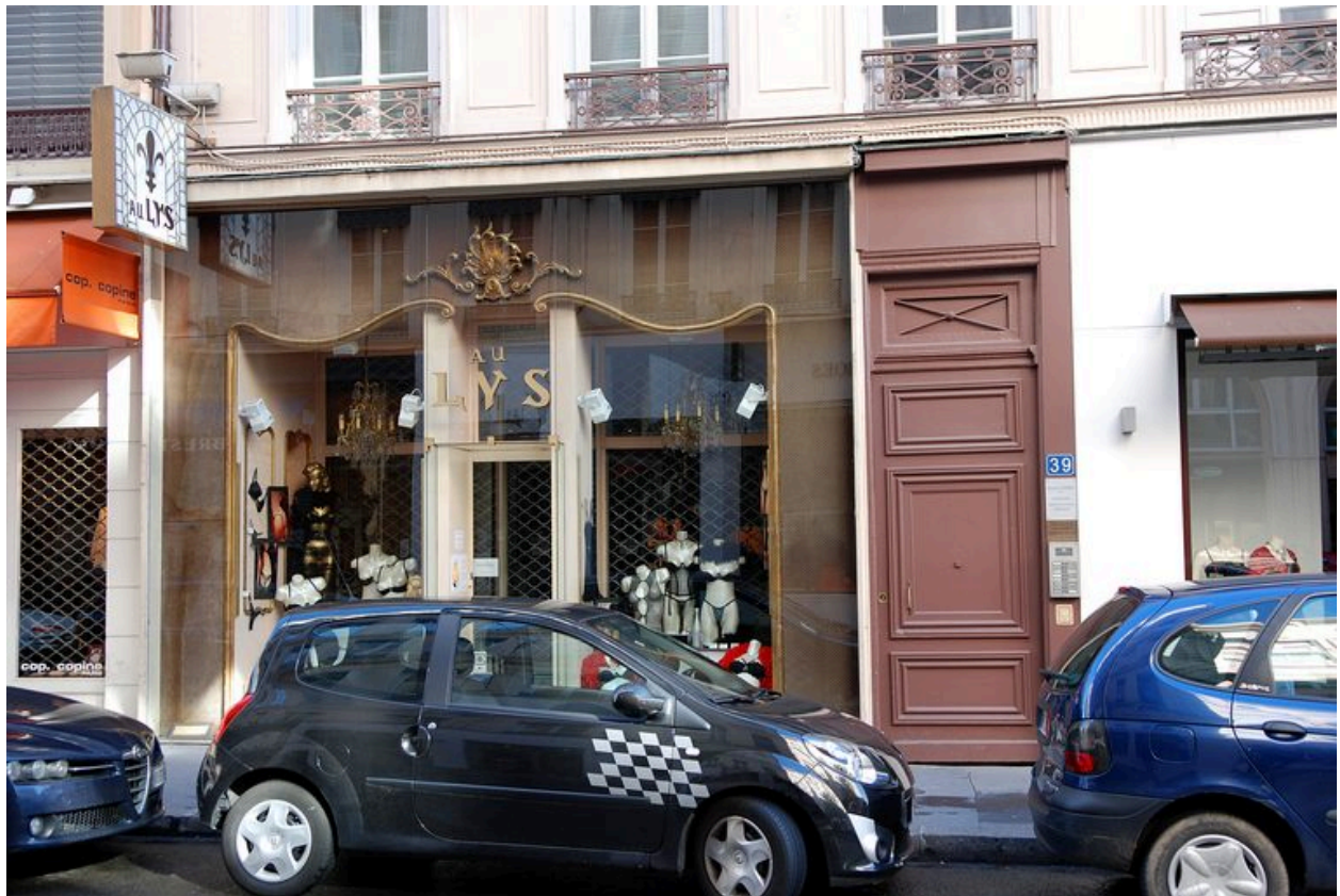
Vue partielle du rez-de-chaussée avec, à gauche, une devanture des années 1950
