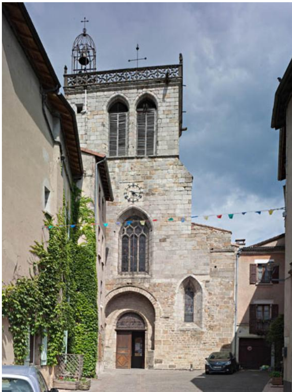
Vue générale de la façade occidentale.
