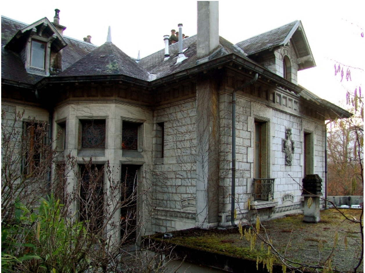
Vue prise du nord-est
