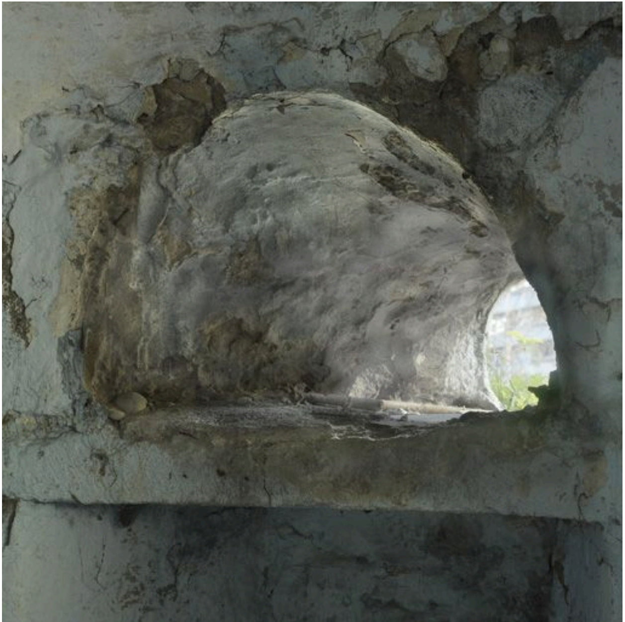
Meurtrière du rez-de-chaussée de la tour nord-ouest
