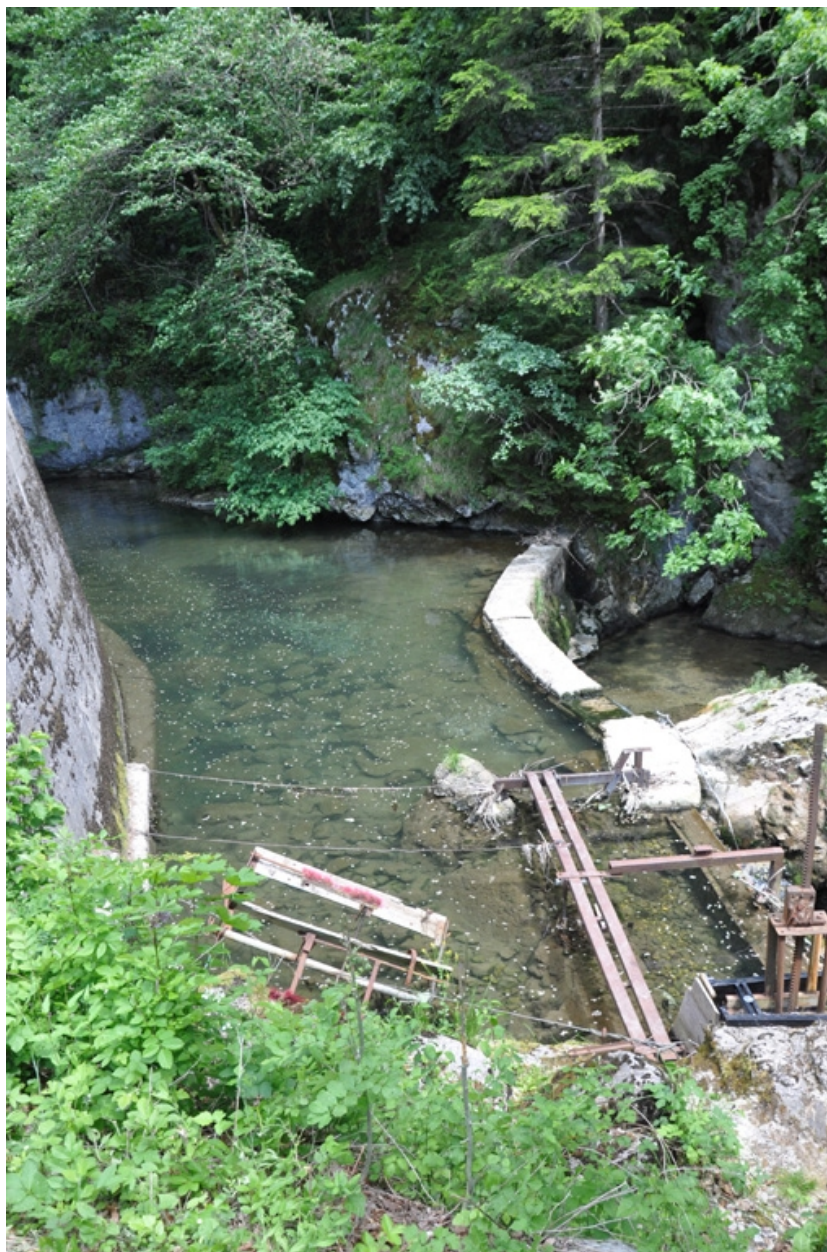
Vue de la prise d'eau et du barrage sur le ruisseau du Cozon
