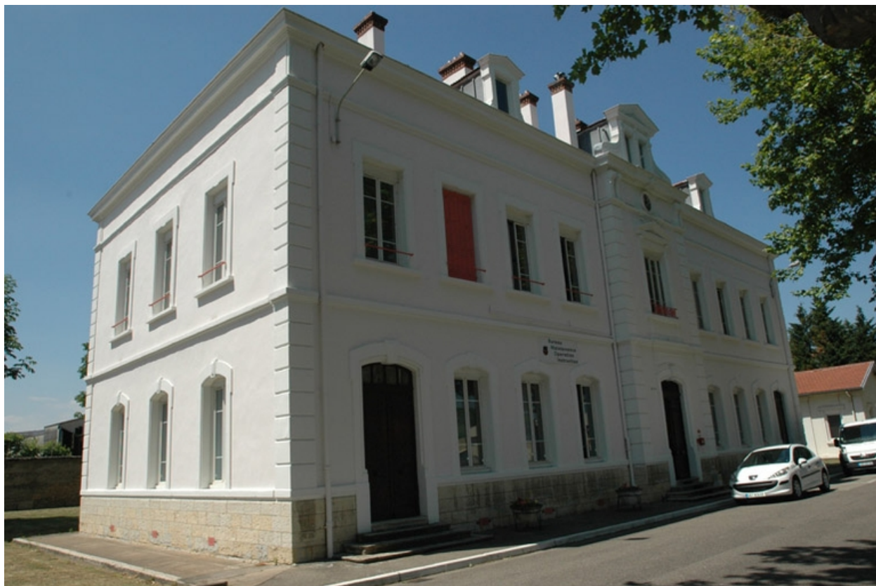
Vue du bâtiment n° 59, construit en 1890
