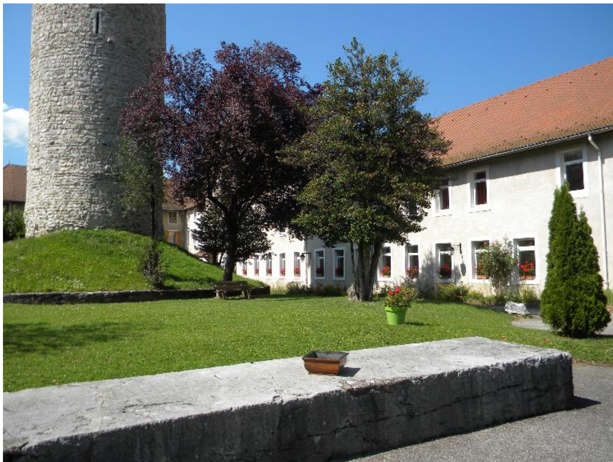
Vue du corps central derrière la tour.
