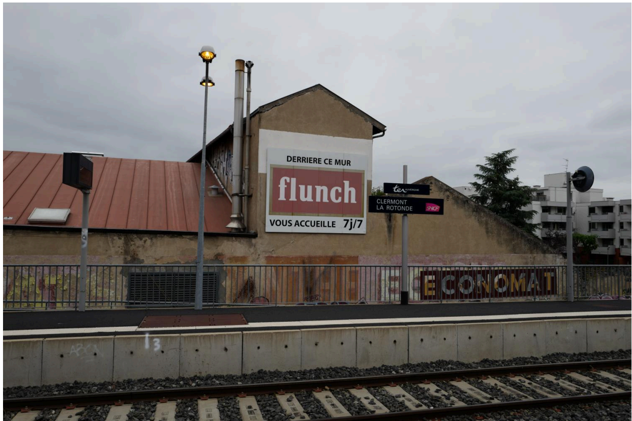
Façade sur la voie ferrée
