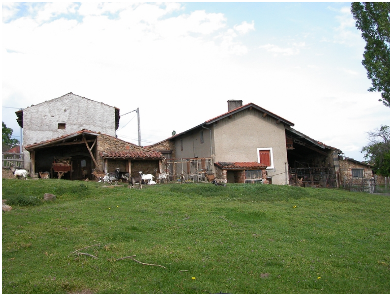
Vue générale depuis l'est.
