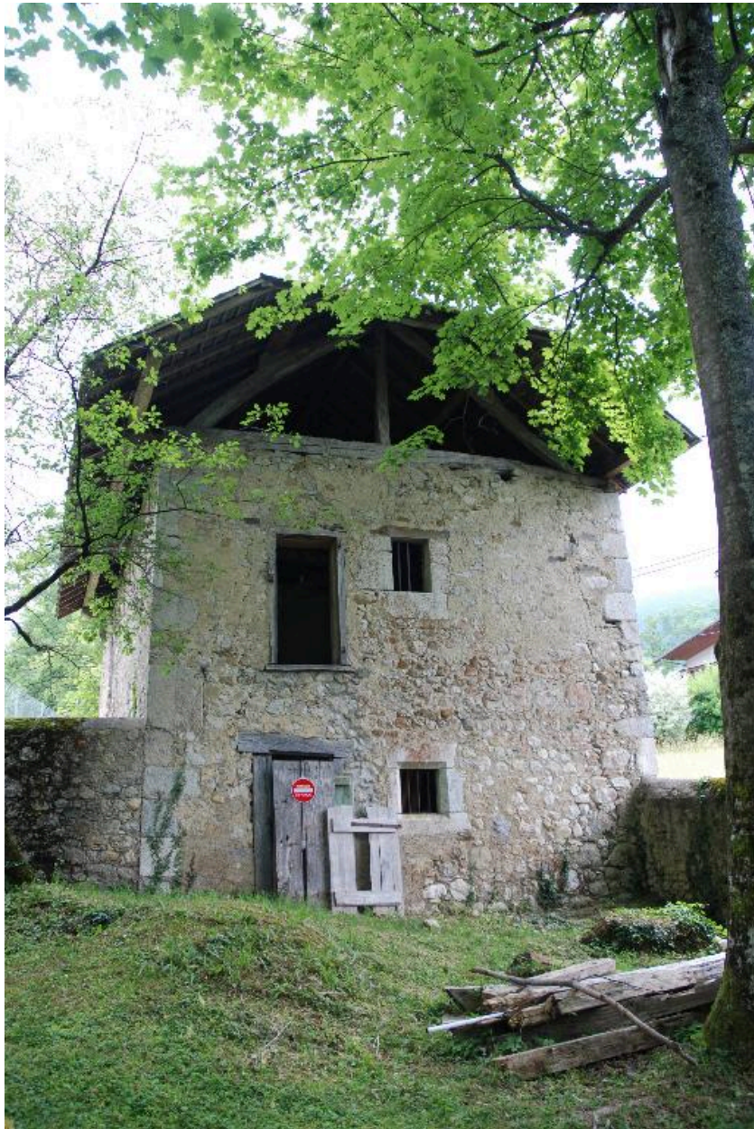
Vue d'ensemble de face du logis de l'ancienne ferme du château.
