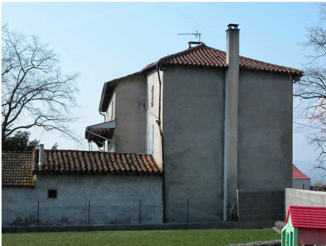
Vue latérale du logis.
