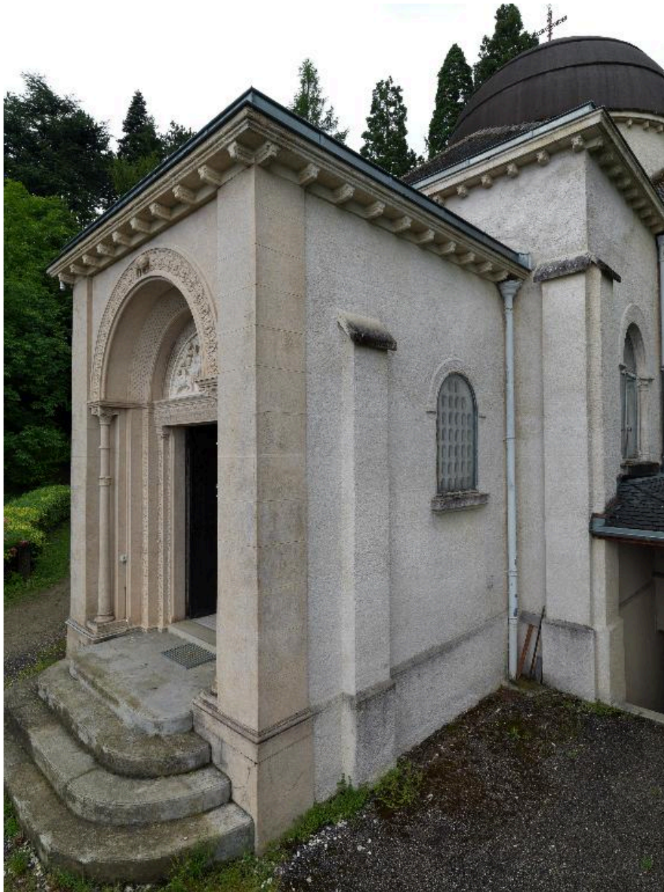
Vue d'ensemble du portail d'entrée de la chapelle depuis le sud-ouest.
