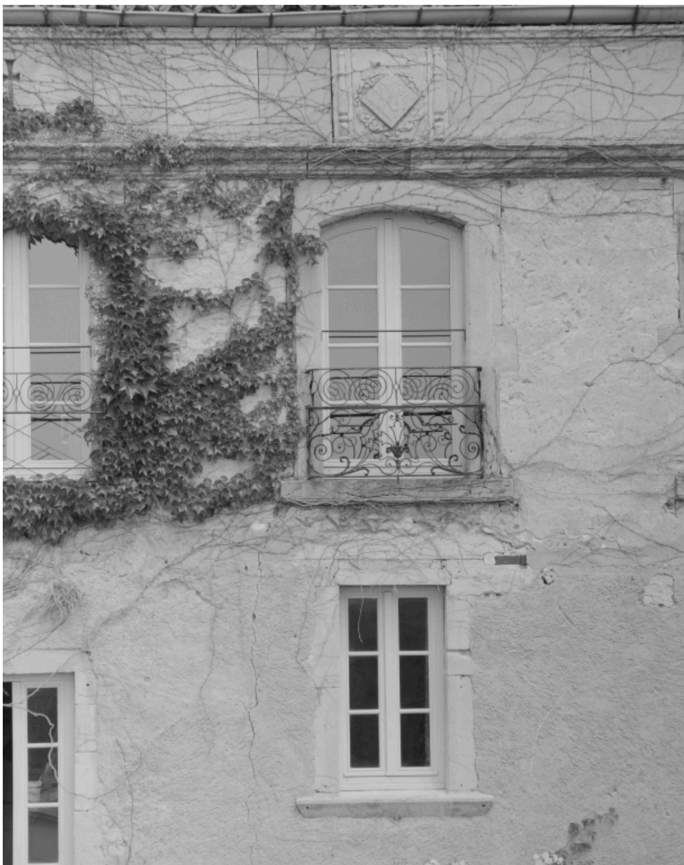
Bâtiment d'entrée. Façade sud. Détail montrant diverses baies et les ornements de la corniche.
