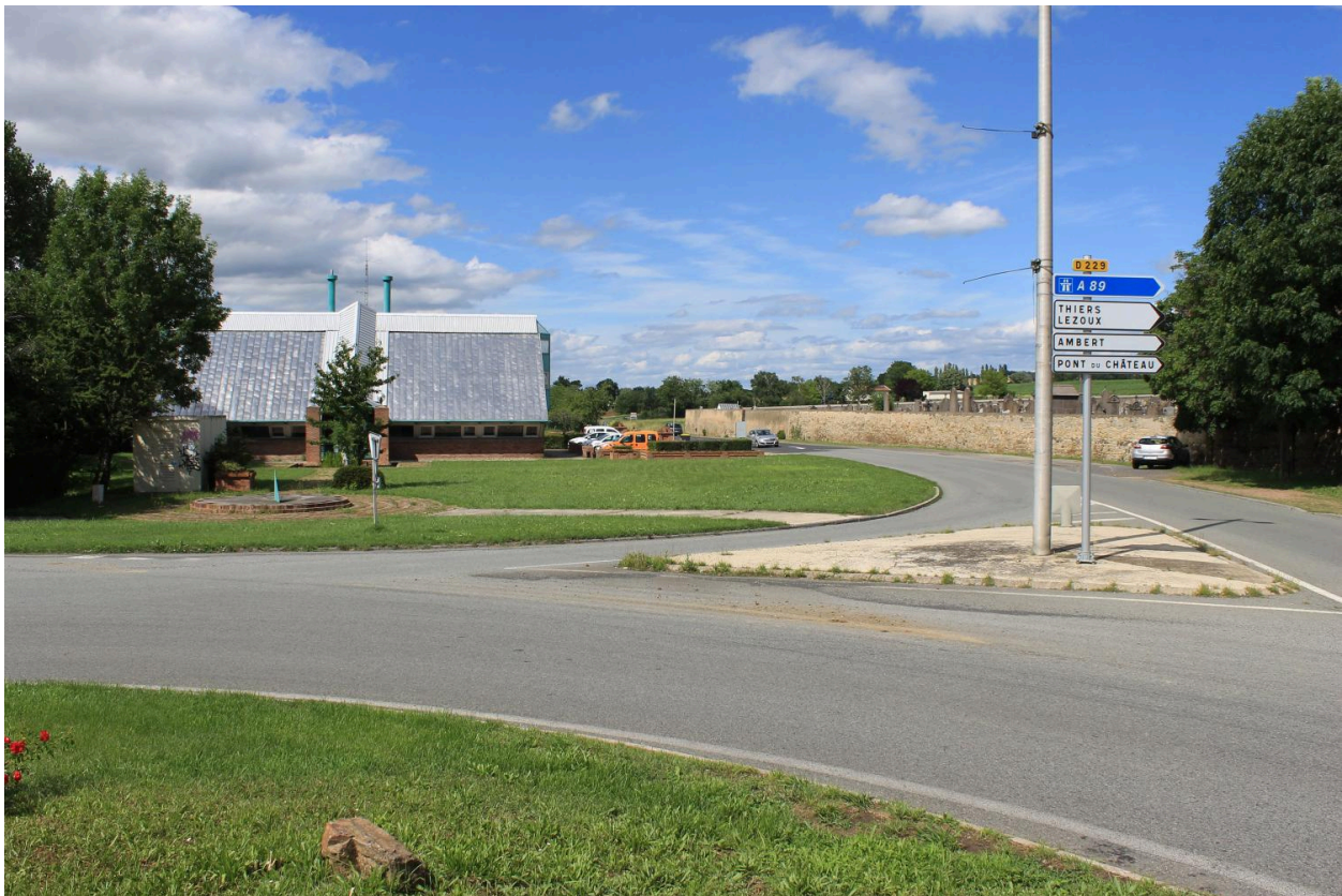
Billom, subdivision de la DDE, vue générale depuis le rond-point.
