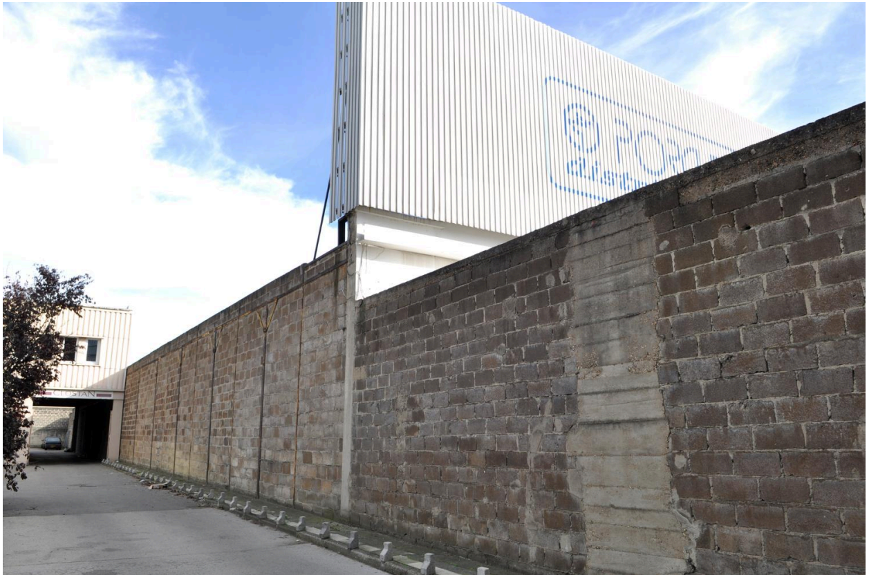
Vue nord du site matériau
